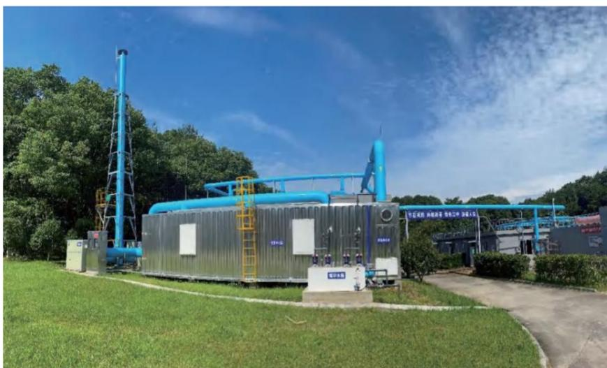
污水处理站废气加盖除臭装置
